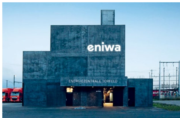
Centrale energetica di Torfeld ad Aarau (Foto: eniwa)
