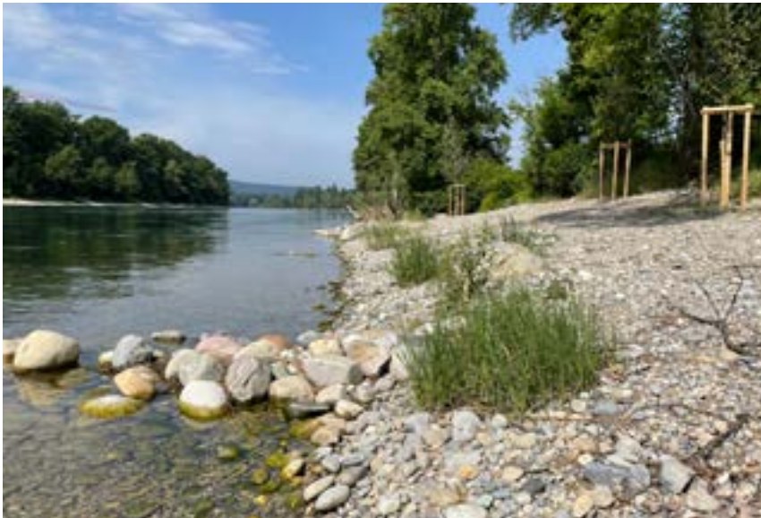
Projet de renaturation Rheinhalde Ouest: Dans la zone «Rheinhalde Ouest» près de Gailingen, un mur de béton de 60 mètre de long a été démolé pour être remplacé par une berge de gravier proche de l'état naturel. Les berges ont été structurées avec des racines, des blocs erratiques et l'installation d'épis, et végétalisées avec de l'herbe à roseau. (Fonds de KW Schaffhausen)
