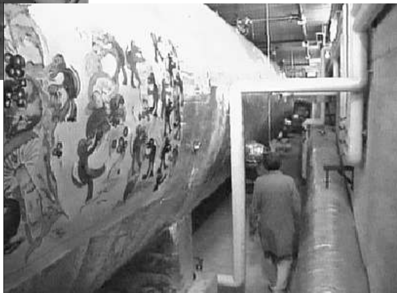
Abb. 15: Eine liegende, zylindrische Fermentereinheit zur thermophilen Vergärung von 5'000 t/a. Rechts neben dem Angestellten eine isolierte Substratleitung.
