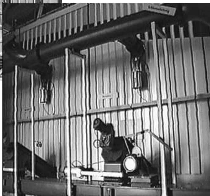
Abb. 24: Die modular nebeneinander angeordneten Behälter für Hydrolyse, Säurebildung und Methanisierung.
