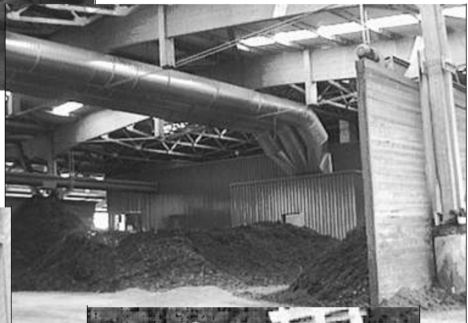
Abb.20: das überdeckte Aussenlager für Kompost mit den riesigen, aus der Halle austretenden Abluftrohren.
