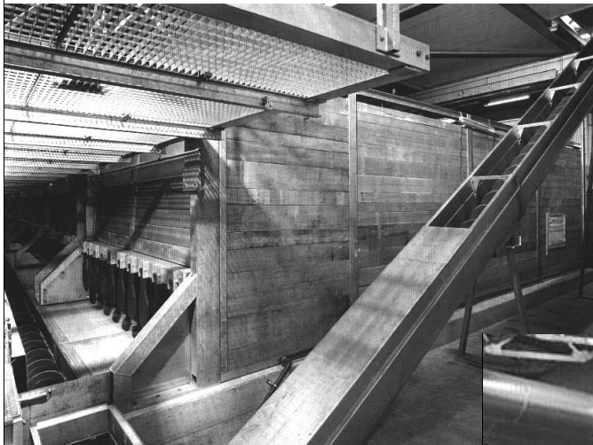
Abb. 21 (unten links): Biowäscherturm
