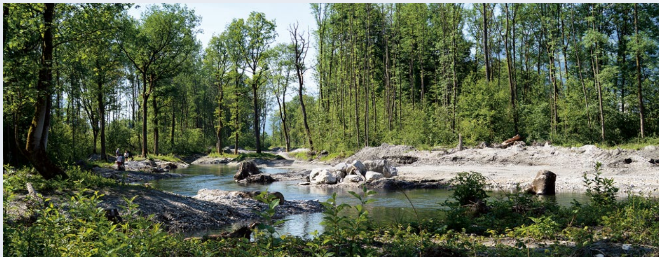
Le nouveau tronçon renaturé du canal intérieur de Werdenberg (Photo: Werdenberger Binnenkanal-Unternehmen)
