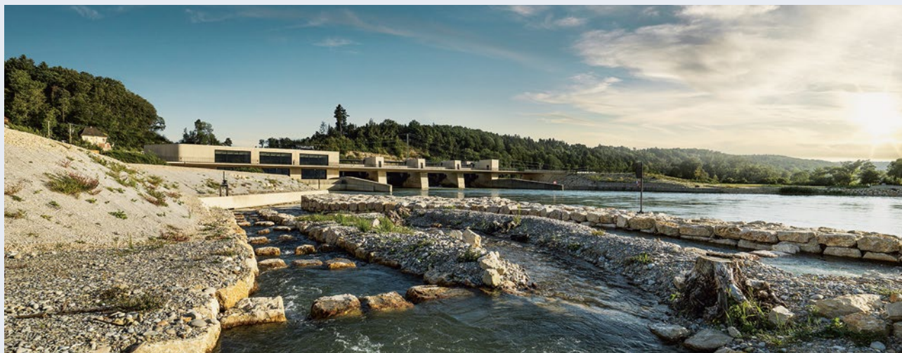
La centrale rénovée de Hagneck s'intègre de manière harmonieuse dans le paysage. (Photo: BKW)
