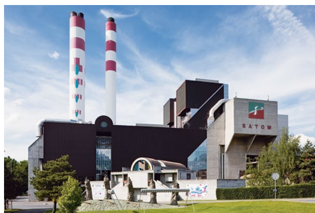
L'UIOM de la SATOM SA à Monthey a été la première installation à se voir attribuer la Charte climatique. Elle prévoit une certification avec naturemade ressources star en 2018. (Photo: SATOM SA)
