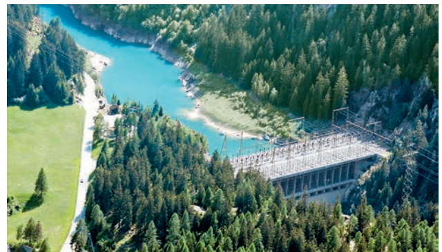
Les Kraftwerke Hinterrhein AG ont finalisé la réalisation des mesures exigées pour l'assainissement des débits résiduels en 2014. (Photo: Kraftwerke Hinterrhein AG)
