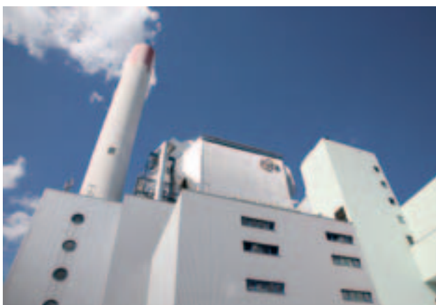
Usine d'incinération des ordures ménagères de Bâle
