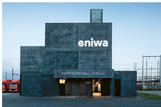
Centrale énergétique de Torfeld à Aarau (Photo: eniwa)
