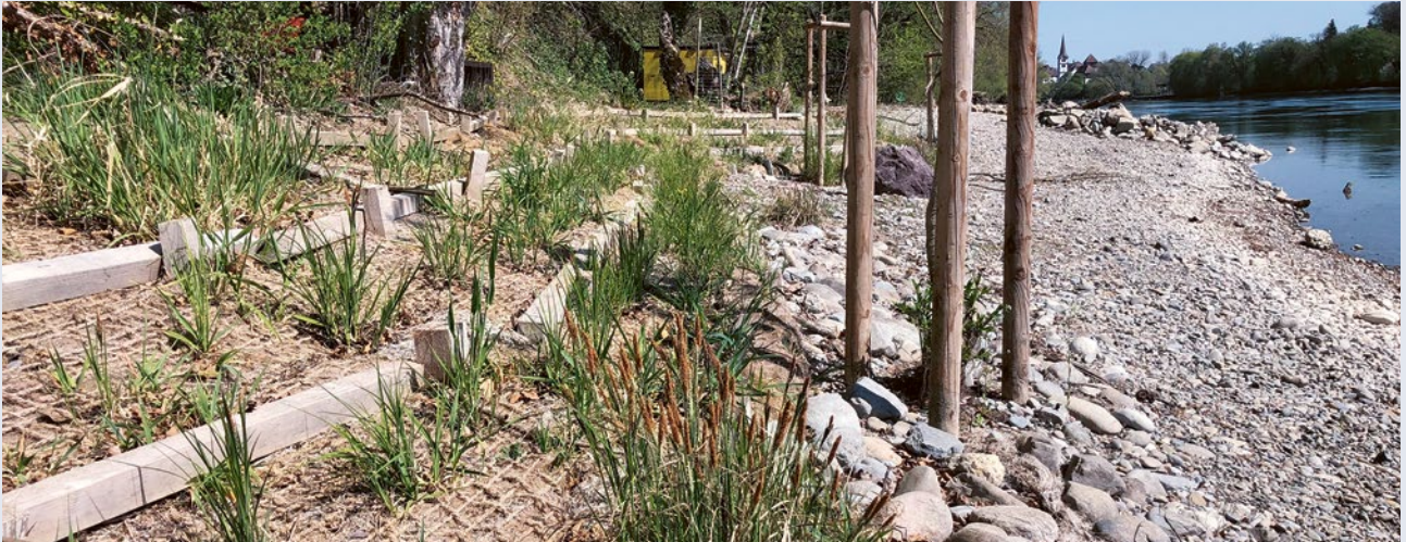
Kokos- und Schafwollmatten wurden mit einheimischen Pflanzen wie Rohrglanzgras und diversen Seggenarten bepflanzt und bilden einen naturnahen Uferschutz (Foto: SH Power)
